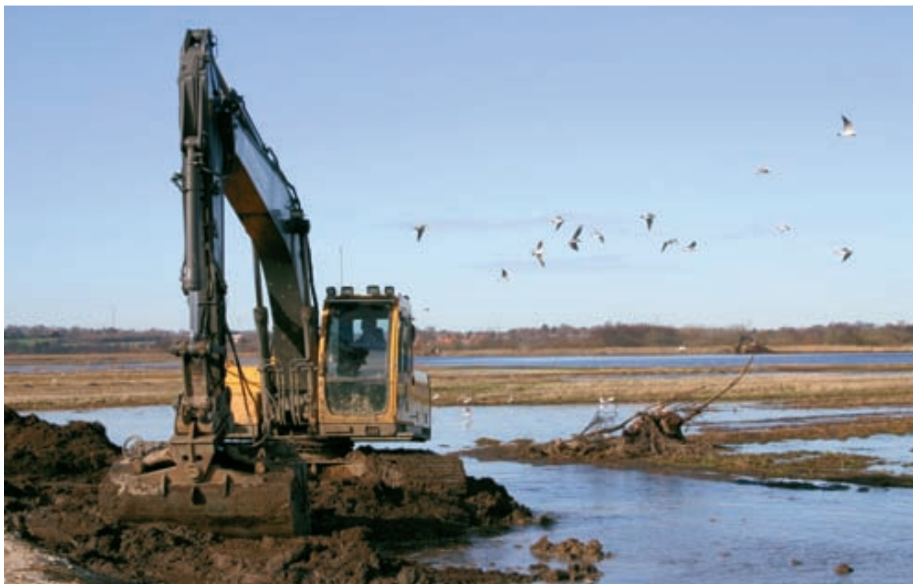
I efteråret 2003 gik gravemaskinerne i gang med at rydde projektområdet for træer og løhegn samt diger og kanaler.
