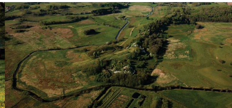
Ved Runkenbjerg slår Vejle Å et sving på 90 grader og løber stik nord
